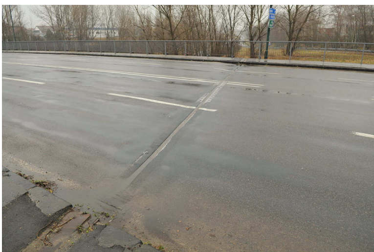
obr.8 propadlý, zatečený povrchový mostní závěr u Hodonínské opěry, hluboké koleje ve vozovce
