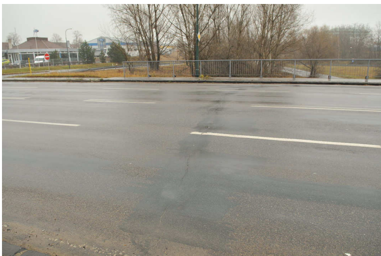
obr.7 podpovrchový mostní závěr u Brněnské opěry, příčné trhliny
