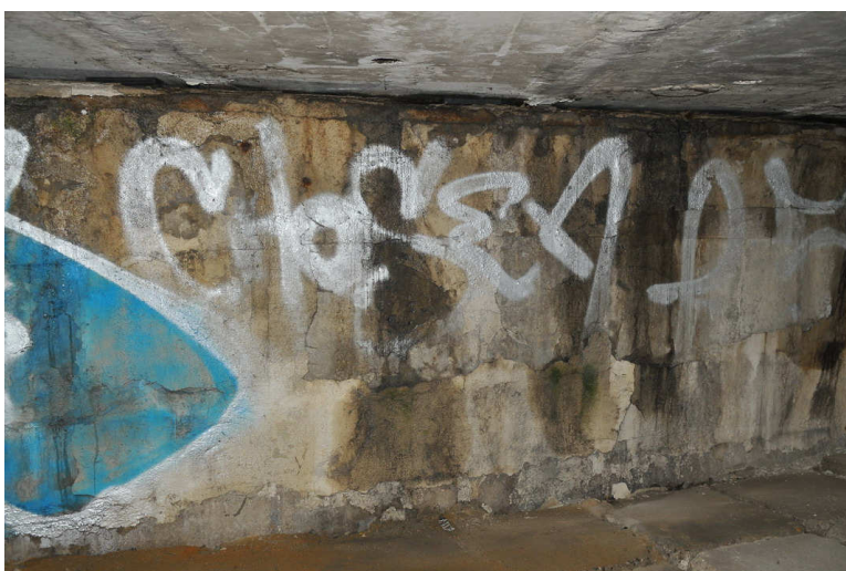
obr.3 rozpad betonu protečených úložných prahů opěr
