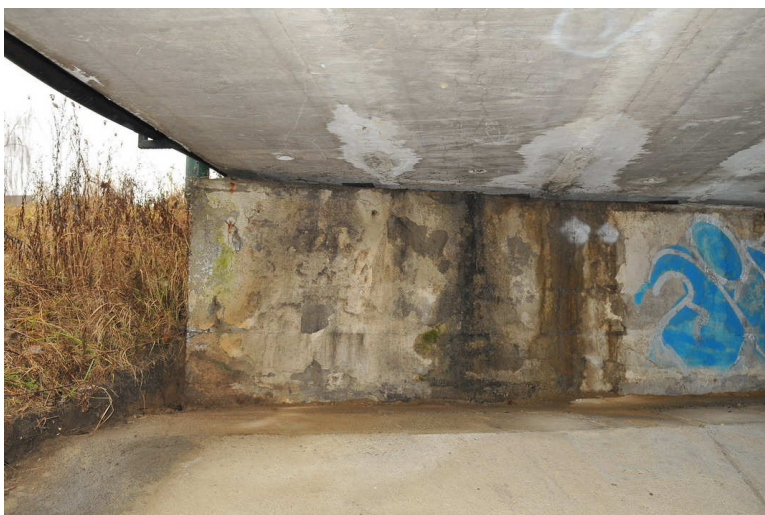
obr.10 pohled na provlhlé opěry pod mostem
