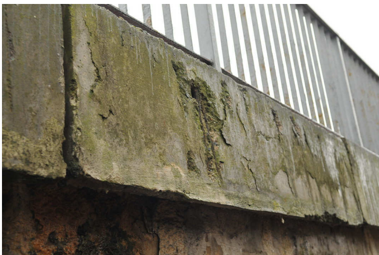
obr.11 degradace betonu říms
