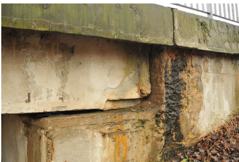
obr.9 zatékání dilatací, stav protečených úložných prahů, říms a křídel
