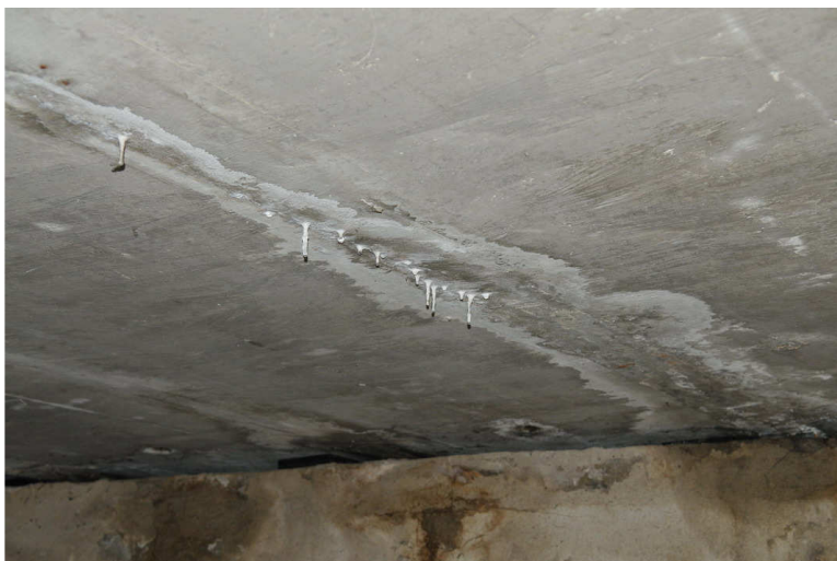
obr.12 podhled nk, spáry mezi nosníky KA 73
