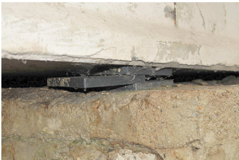
obr.6 nefunkční ložisko pod krajním nosníkem u Hodonínské opěry
